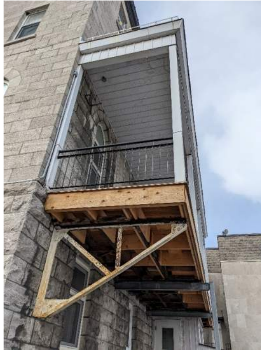
Photo 2: Balcon côté est
