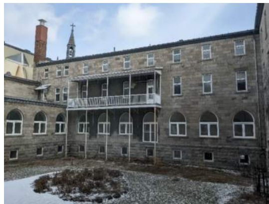
Photo 5: Balcon - cour intérieure
