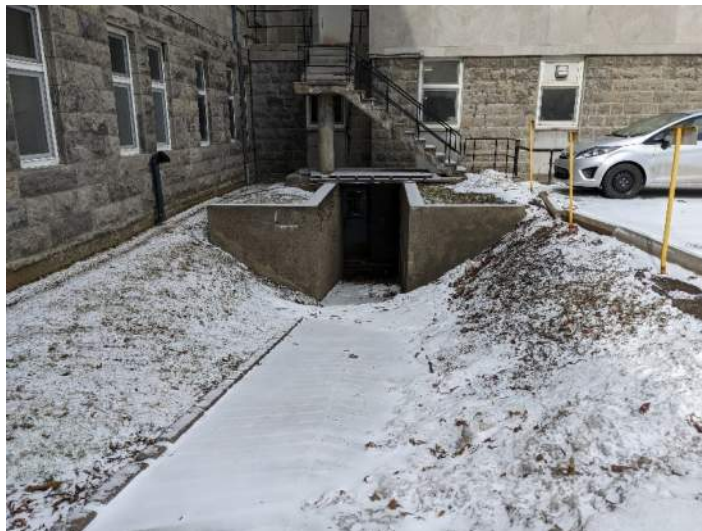
Photo 6: Ouvrages en béton à démolir pour la nouvelle issue
