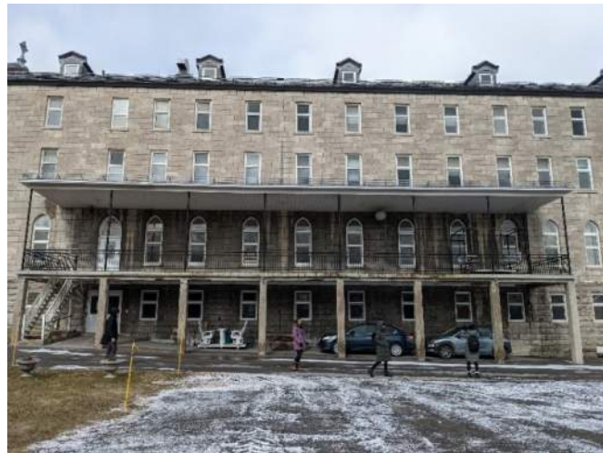
Photo 3: Balcon sud - Vue d'ensemble
