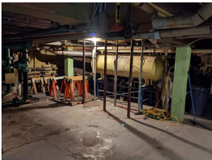
Photo 1 : Mise à jour de l'étaieage dans la chaufferie
