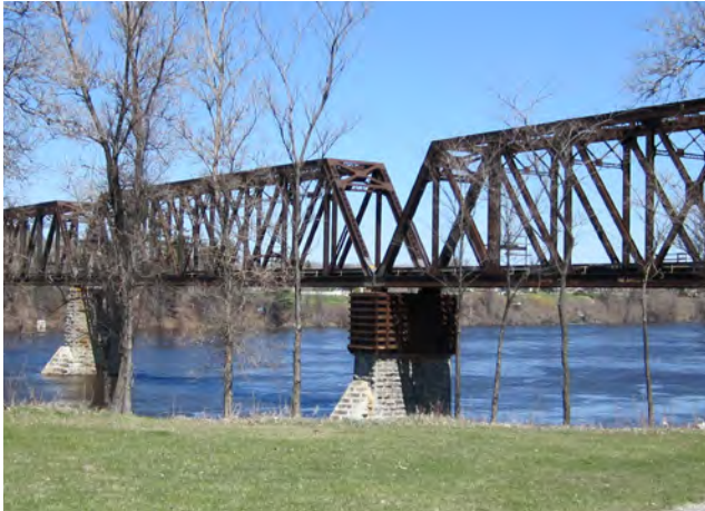
Figure 1.10 – Rayonnement acoustique des structures métalliques des ponts.
