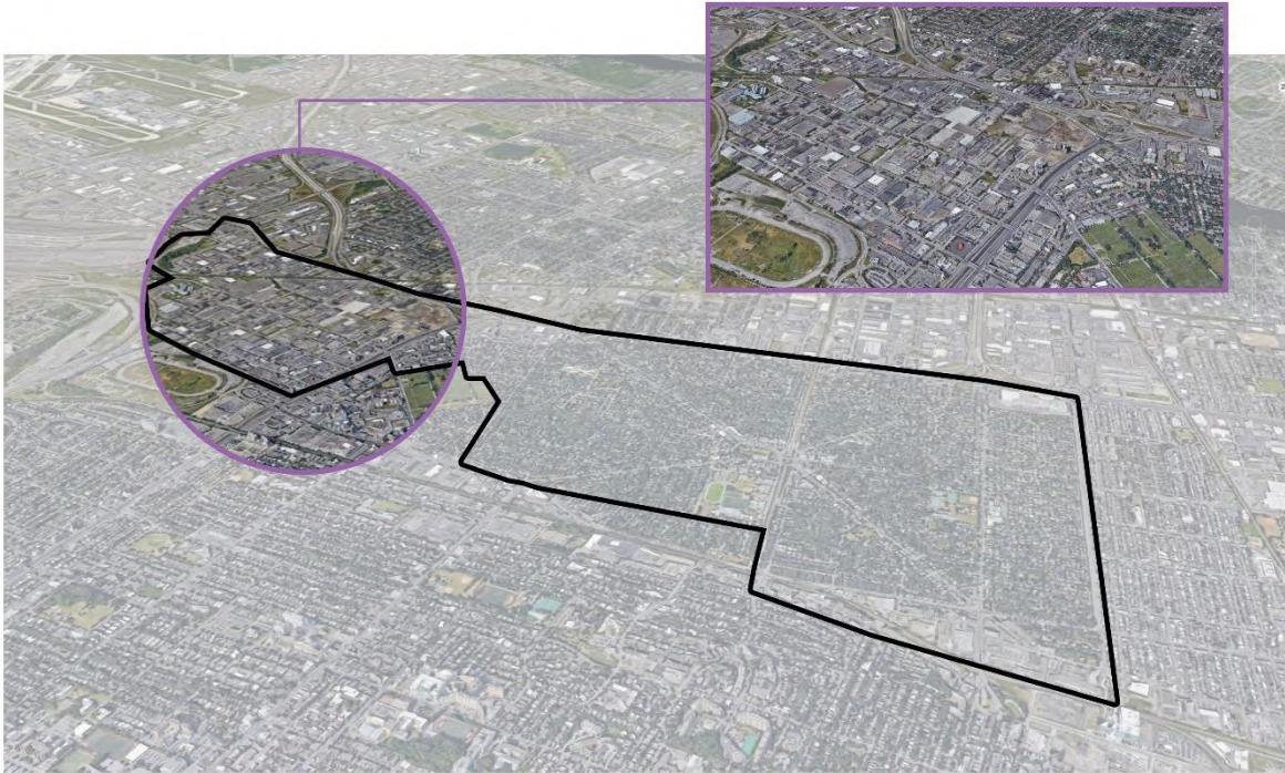
Figure 21 : Localisation du parc industriel dans Ville Mont-Royal.
