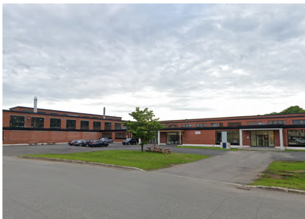
Figure 10 : L'USINE dans l'ancien bâtiment de l'Arsenal de Saint-Malo.
