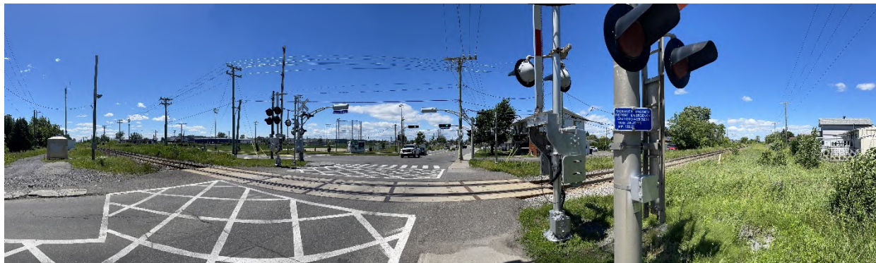
Figure 13 : Vue panoramique du passage à niveau de la rue Saint-Paul.
