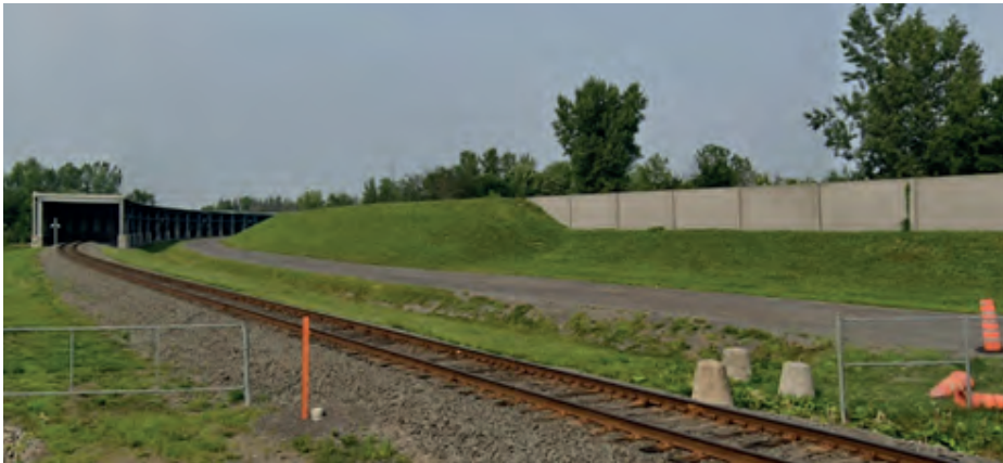
Figure 5.7 – Butte et mur antibruit à l'ouest du secteur Le Gardeur à Repentigny.
