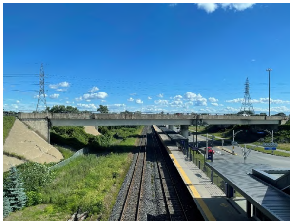
Figure 15 : L'autoroute 40 qui passe au-dessus de la gare EXO.
