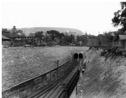
Figure 7 : Le tunnel sous le Mont-Royal, vue vers le nord depuis les alentours de la rue de la Gauchetière.
