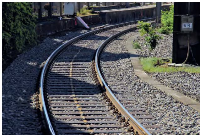
Figure 1.7 – Portion de voie courbe pouvant induire des bruits de freinage et de grincement.
