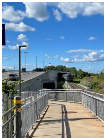
Figure 14 : Tunnels de la gare EXO.
