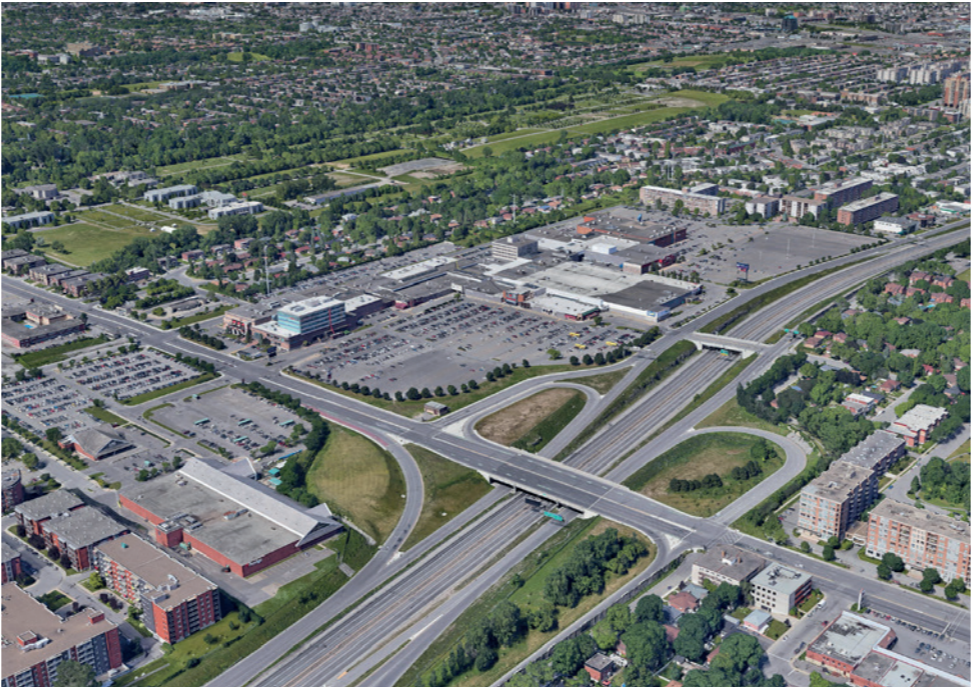
3 - Vue aérienne depuis le sud-est Source: Google Earth - Atelier Robitaille Thiffault - Page 8
