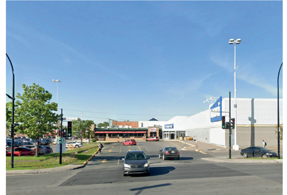
2- Entrée rue de Boucherville Source: Google Street View - Atelier Robitaille Thiffault - Page 7
