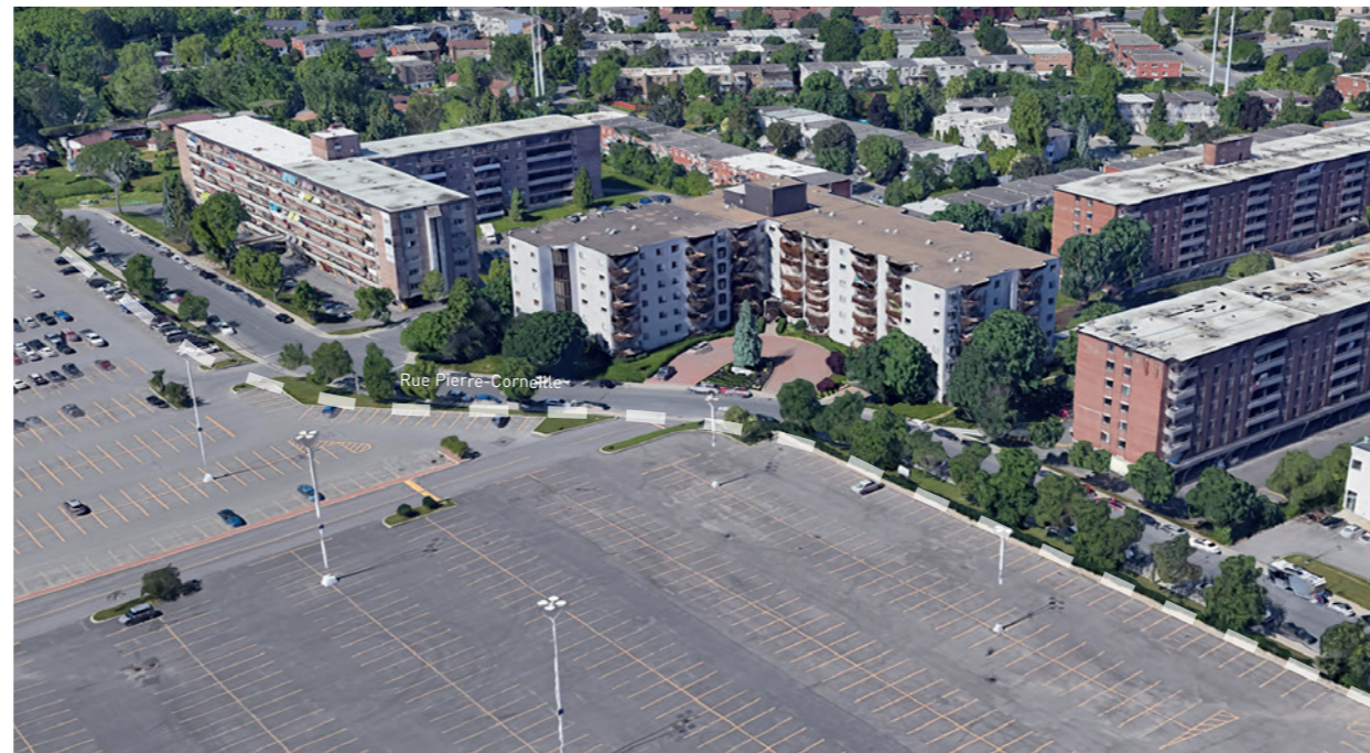
2 - Vue aérienne de la limite nord du site avec la rue Pierre-Corneille et l'Avenue de l'Authion
