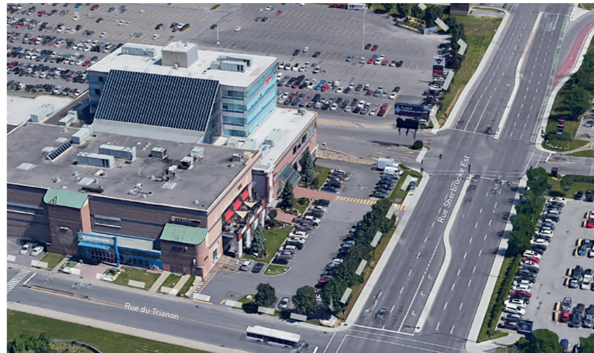
2 - Vue aérienne de la limite sud du site en relation avec la rue Sherbrooke Est Source: Google Earth - Atelier Robitaille Thiffault - Page 17
