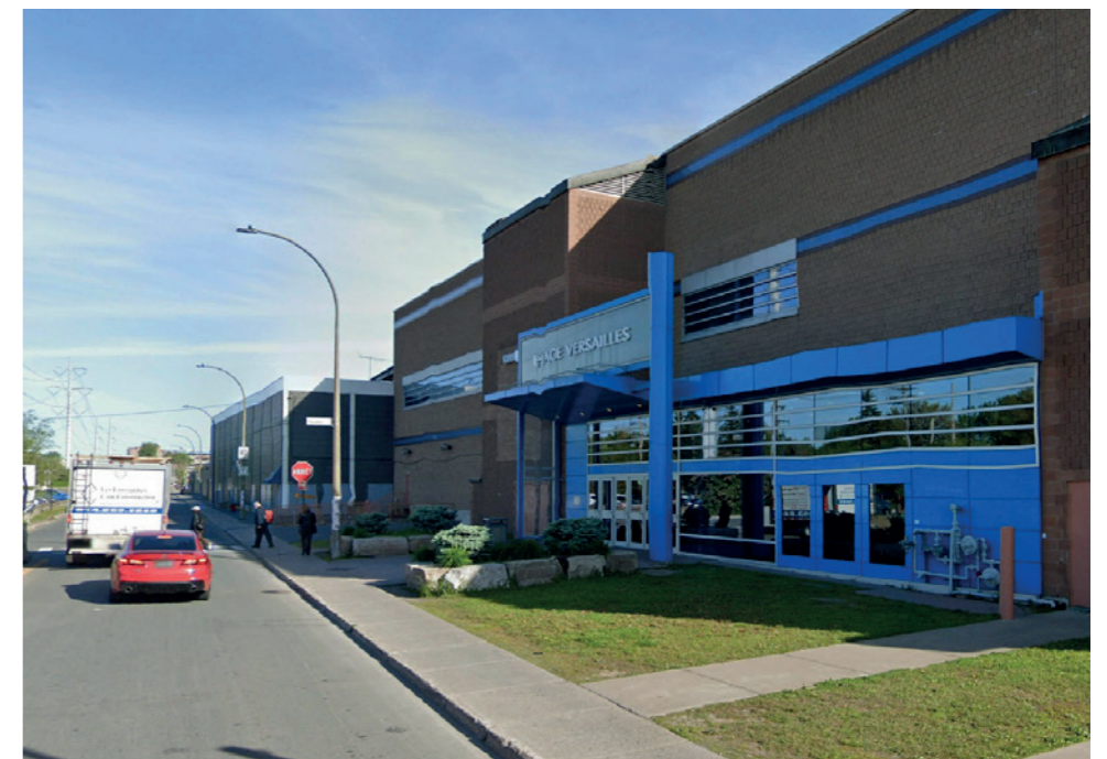
4 - Entrée rue du Trianon Source: Google Street View - Atelier Robitaille Thiffault - Page 7
