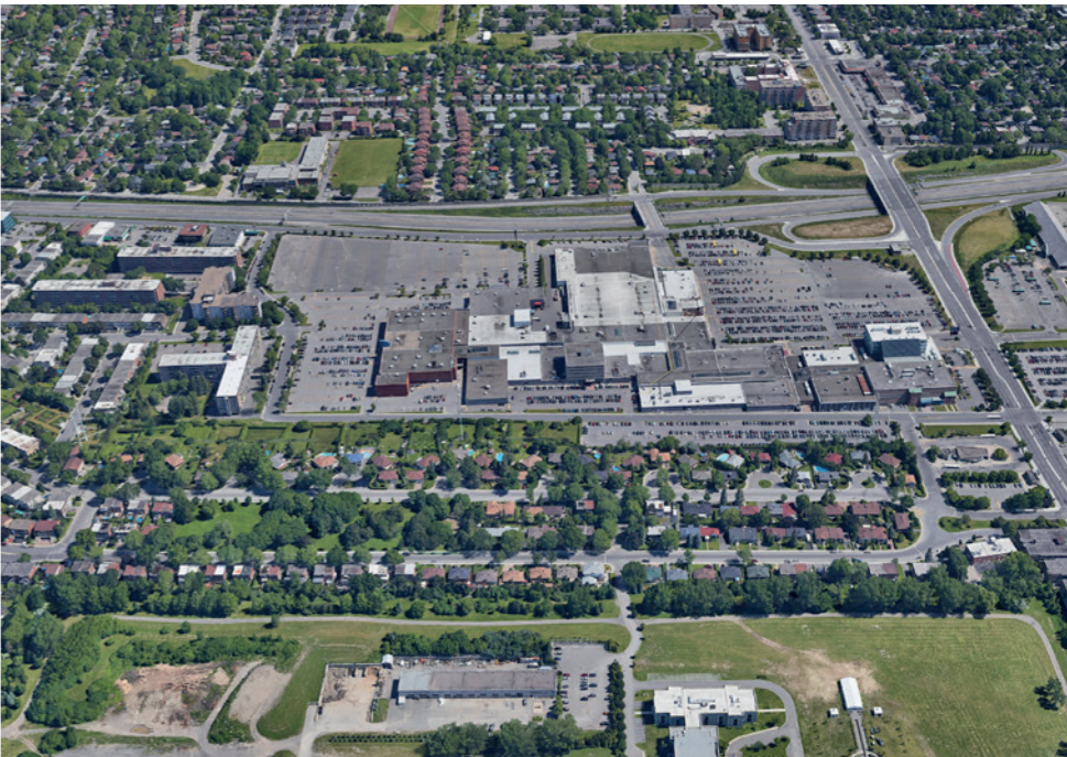
2- Vue aérienne depuis l'ouest Source: Google Earth - Atelier Robitaille Thiffault - Page 8
