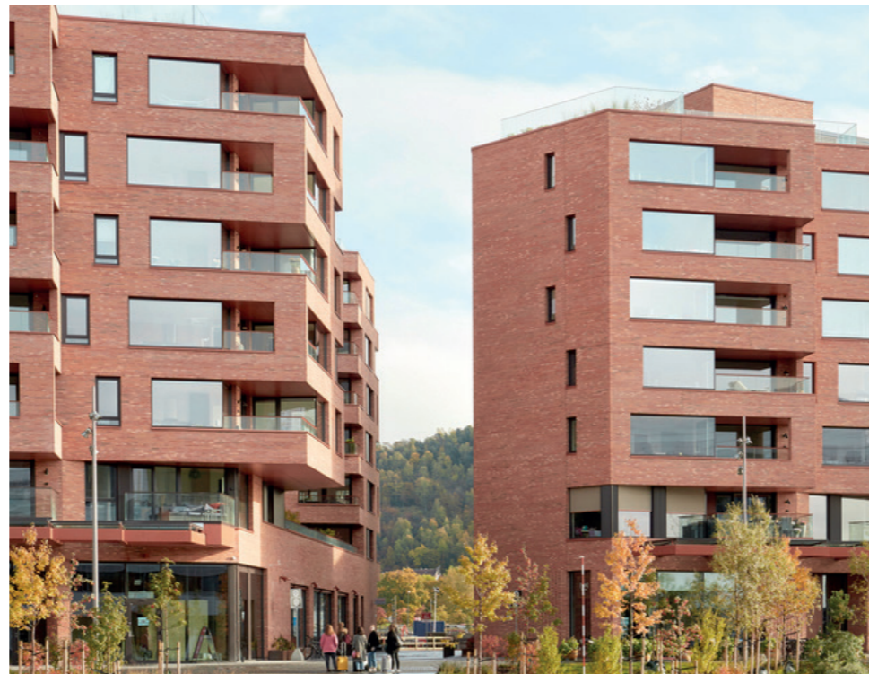
Complexe résidentiel, Oslo, Norvège - Lund+Slaatto Architects Source: Atelier Robitaille Thiffault - Page 45
