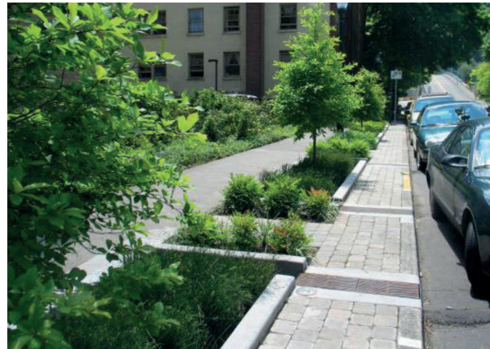
Rue avec infrastructure verte, San Francisco Source: spur.org
