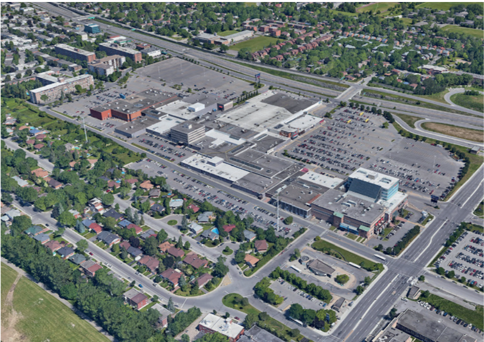
1 - Vue aérienne depuis le sud ouest Source: Google Earth - Atelier Robitaille Thiffault - Page 8
