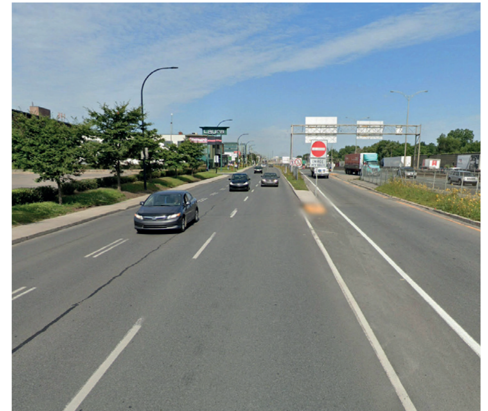
2 - Vue vers le Nord depuis la rue de Boucherville Source: Atelier Robitaille Thiffault - Page 20
