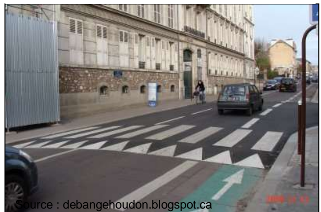
Figure 20: Passage piéton surélevé à Versailles
