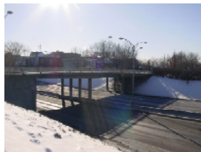
2003, Viaduc du boulevard Gouin. Source : Groupe Cardinal Hardy
