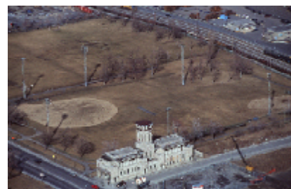
2000, Caserne Létourneux et parc Champêtre. Source : Ministère des Transports
