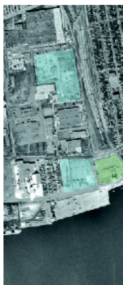
2000, Emprise du pont-tunnel Louis-Hippolyte-Lafontaine, Orthophoto (détail). Source: Ville de Montréal
