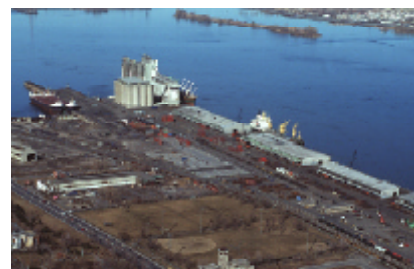
2000, Installations portuaires. Source : Ministère des Transports
