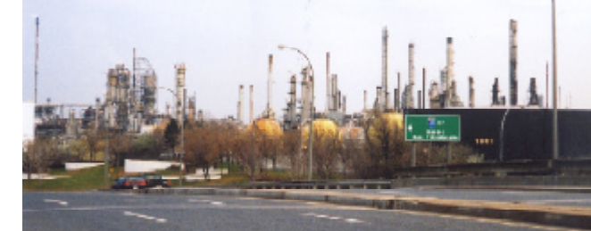
Cheminées et brûleurs derrière les réservoirs
