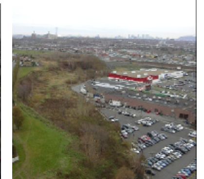
L'important talus gazonné versus les quais de livraison
