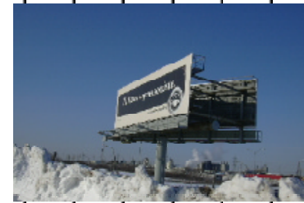
Méga-publicités installées dans les zones industrielles: des structures imposantes, sources de pollution visuelle à éliminer
