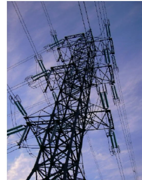
Structure métallique d'un pylône
