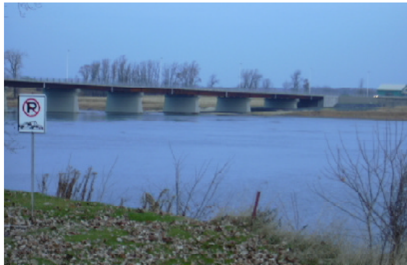
Le pont Le Gardeur, vue du parc de la pointe de l'île.
