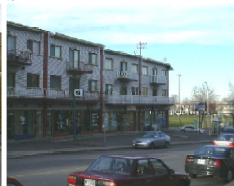
Rez-de-chaussés commerciaux et habitations
