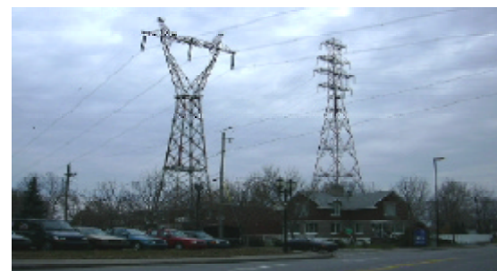
Une habitation au pied des pylones électriques
