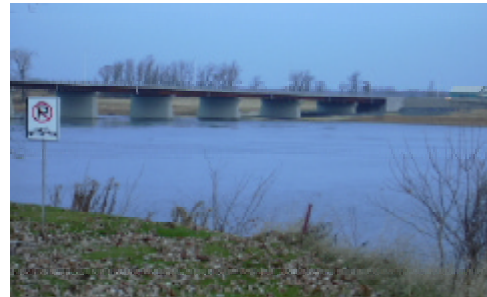
Le pont vu du parc de la Pointe
