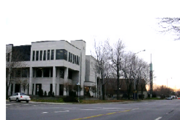
L'hôtel de ville de Montréal-Est, construction d'envergure
