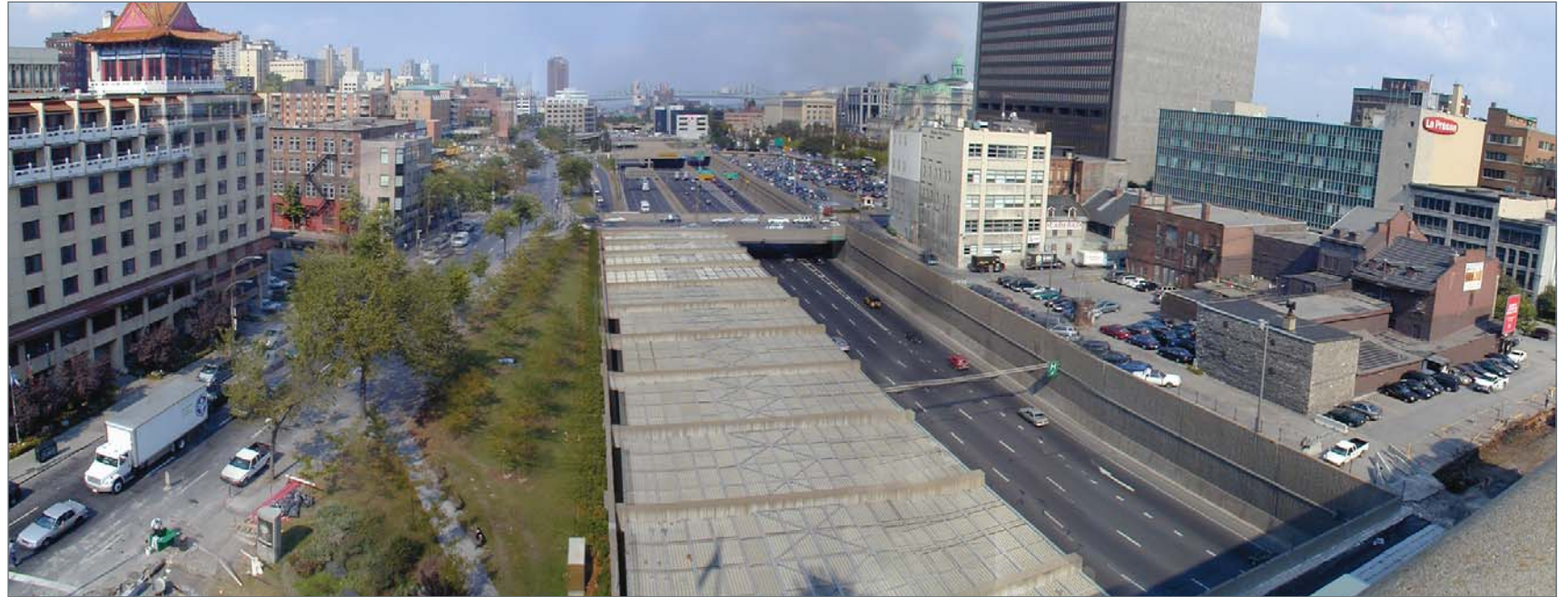
Vue d'ensemble vers l'est
