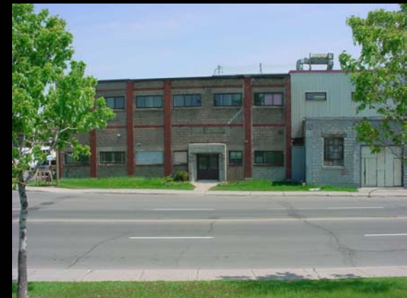
Rosemont (îlot central)
