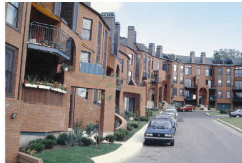
Projet Berge de l'Anse, Montréal-Nord Architectes: Groupe Cardinal Hardy
