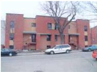
Coop l'Oasis - Hochelaga-Maisonneuve 8 logements Laverdière et Giguère
